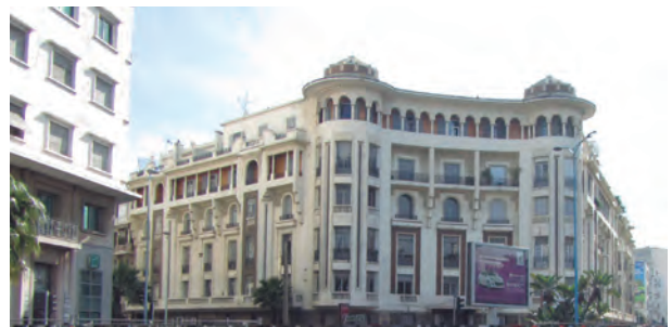
FIGURE 3. Casablanca : Immeuble résidentiel dans la ville européenne.
